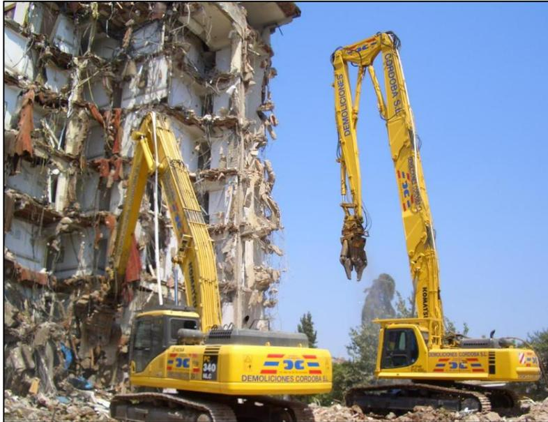
**Figura 19. Demolición con maquinaria**
