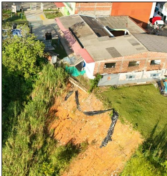
**Figura 20. Talud erosionado**
