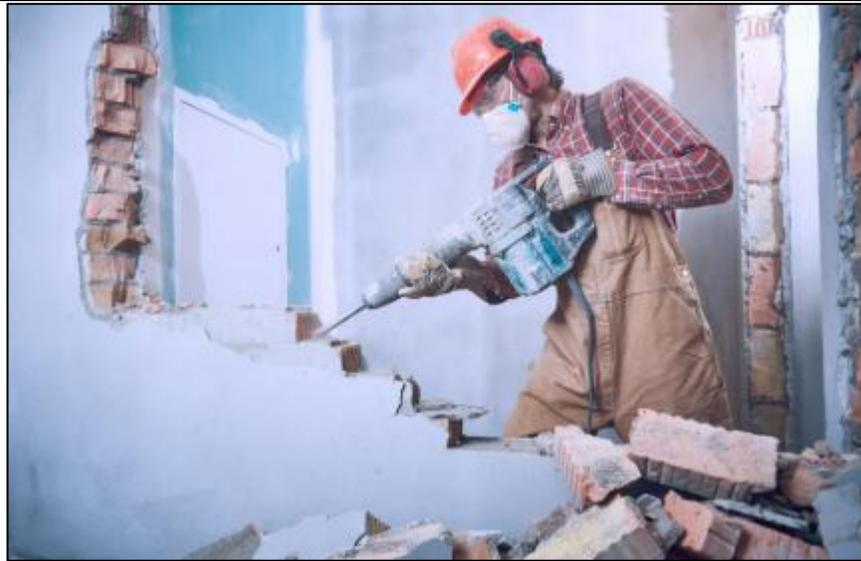
**Figura 18. Demolición manual**
