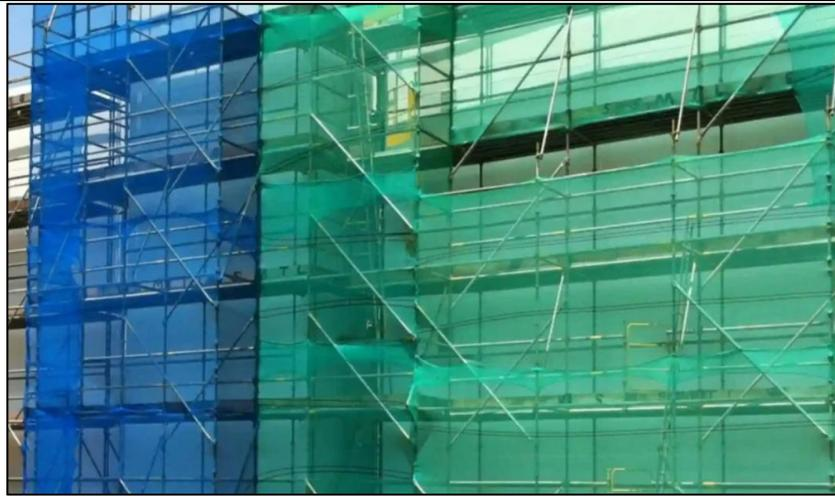
**Figura 17. Cobertores para obras en demolición y/o construcción**
