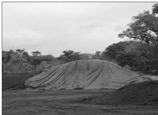
Figura 25. Ejemplo de lonas para cubrir el material.
